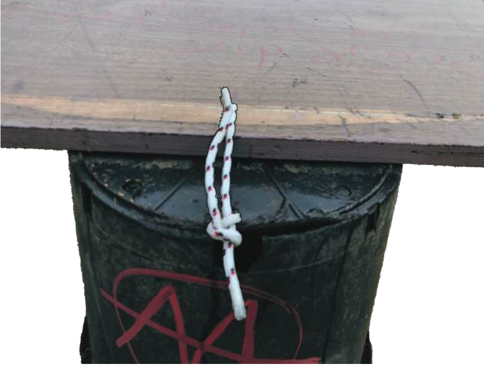
Ahşap ile saksıların bağlantı detayı.
